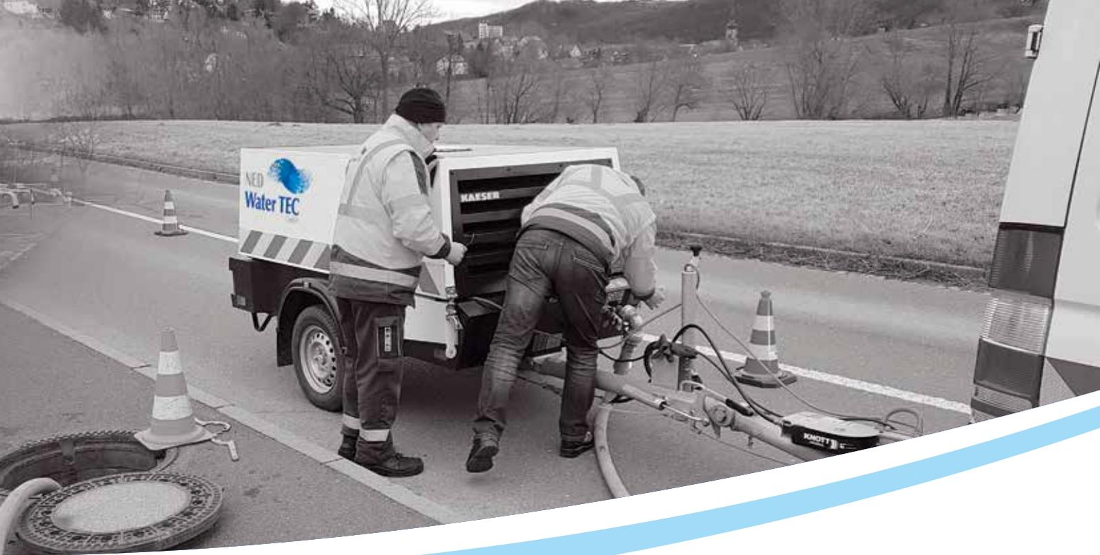
Wir reinigen Abwasserdruckleitungen während des laufenden Betriebes mit unserer „Luftunterstützten Intervallspülung“.
